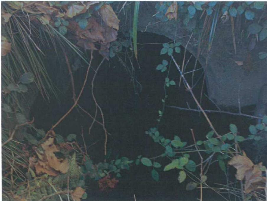
L'ouvrage traversant sous la voie communale est partiellement bouché sur 1/3 de sa hauteur.
